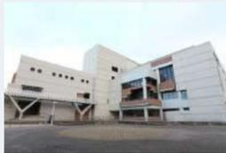
開館してから42年が経つ、新潟市音楽文化会館の外壁改修工事を担当しました。20年前に1回目の外壁改修工事が実施されており、今回の工事は2回目の外壁改修工事となります。遠目では綺麗に見えていた外壁タイルは、間近で見ると破損や劣化したものも多く、補修忘れの無いように1枚1枚打音調査しながら補修作業を行いました。20年後に再度改修工事を予定しているそうですので、それまで綺麗な外観を保ち続けて欲しいです。
